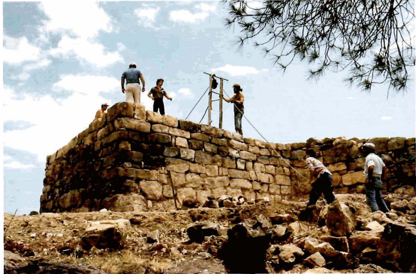
Puntal dels Llops, Olocau. Obres de consolidació i restauració realitzades en 1987.
